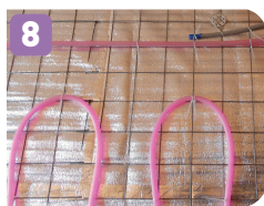
Датчик температуры на расстоянии 1–2 см от трубы (в стяжке)
