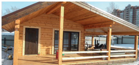
ОТОПЛЕНИЕ ДОМА ИЗ БРУСА, вид на объект
