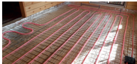
ОТОПЛЕНИЕ ДОМА ИЗ БРУСА, монтаж системы
