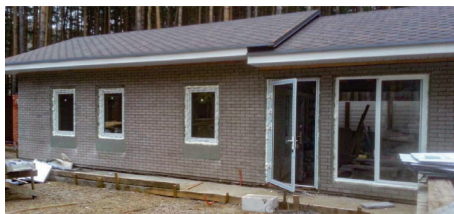
ОТОПЛЕНИЕ ДОМА ИЗ ПЕНОБЕТОННЫХ БЛОКОВ, вид на объект
